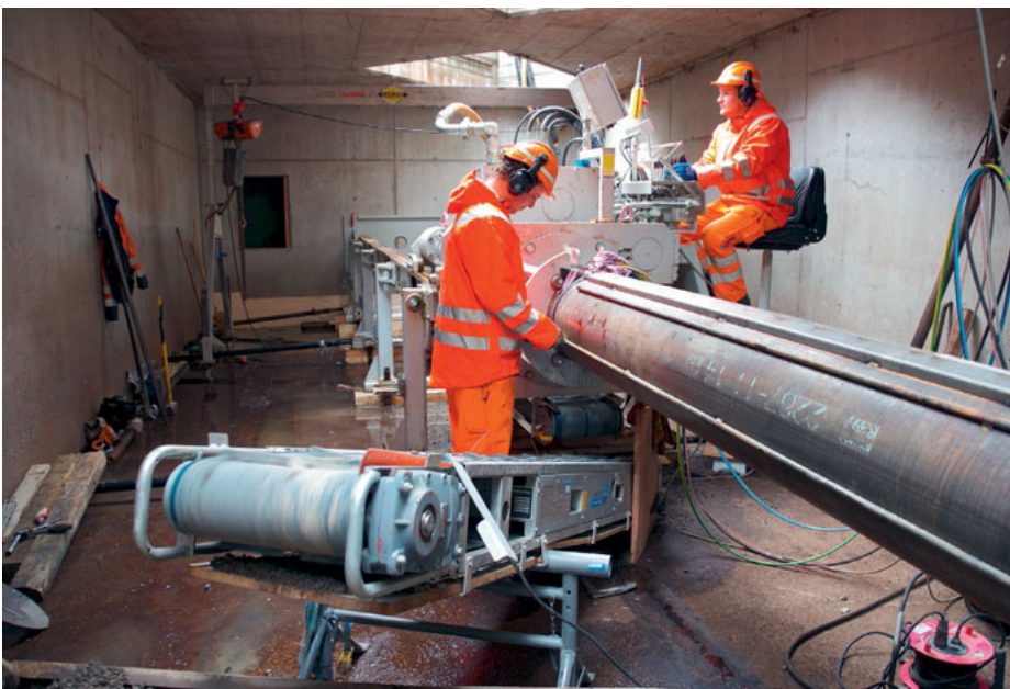
Bohrvortrieb aus dem Schnitzelbunker, der als Startgrube genutzt wurde (Muotathal).
