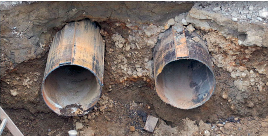
Bahnquerung SBB-Gotthardlinie mit zwei Bohrungen (Steinen).
