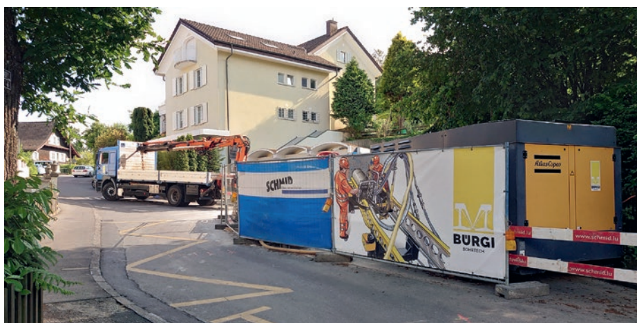
Engste Platzverhältnisse bei der Startgrube.
